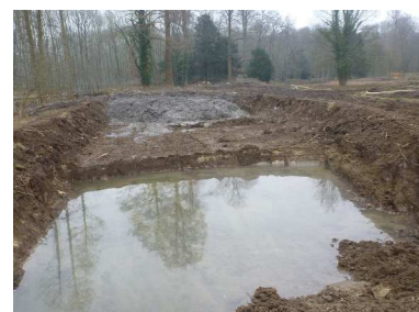
Création de bassin temporaire pour le ressuyage des boues de curage
