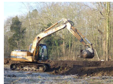
Création de bassin temporaire pour le ressuyage des boues de curage
